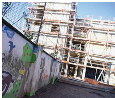
Nimmt langsam Formen an: das neue Gebäude an der Grundschule in Langendiebach. FOTOS: MIKE BENDER
